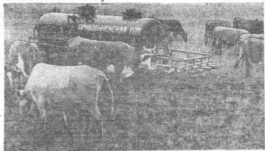
Die Mechanisatoren der Priwolnenskaja-MTS, Gau Stawropol, haben eine alte Zisterne umgebaut und sie als fahrbare Selbsttränke für die Melkkuhherde des Malenkow-Kolchos ausgerüstet. Die fahrbare Selbsttränke faßt 2 Tonnen Wasser. Foto: W. Michalew (TASS-Fotochronik).
