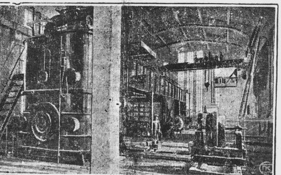
В Ленинградском металлическом заводе закончены работы по постройке и оборудованию в Ленинграде гидравлической лаборатории. Она построена на берегу Невы и представляет собой громадный корпус, где оборудован ряд больших каналов для испытаний моделей турбин. Стоимость оборудования и постройки лаборатории — 250.000 р. Оборудование собственной гидравлической лаборатории избавляет завод от необходимости посыпать турбины на испытание в научные институты.
