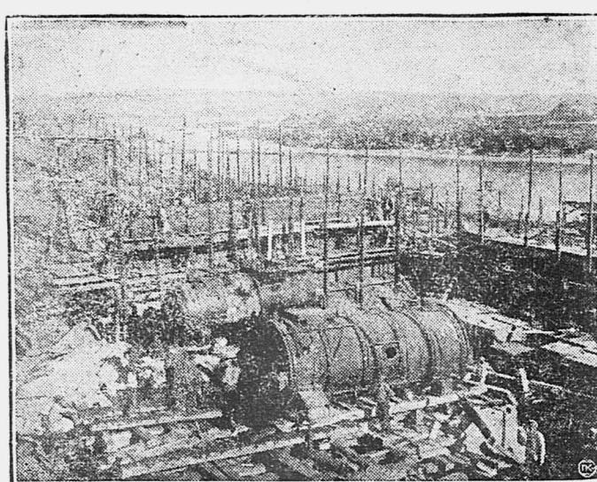
Постройка временной силовой станции на 1.000 килловат для обслуживания нужд строительства.
