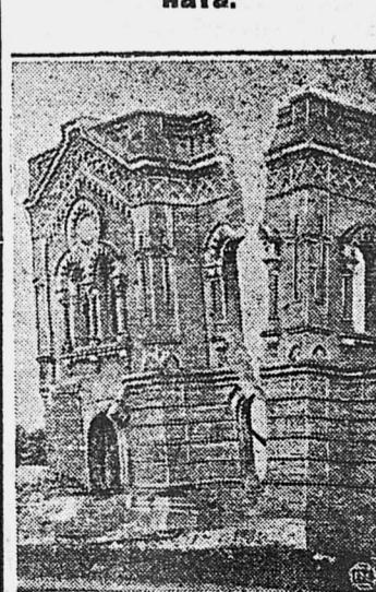
Население станции Крыловской Кубанского округа, решив выстроить у себя мельницу, маслобойку и электростанцию, постановило разобрать стены недостроенной церкви и использовать ее кирпич. Для разрушения стены подталкивались у основания, а с противоположной стороны произошло падение на них. Из стекла выбрано около одного миллиона цеховых кирпичей. На снимке момент падения капитальной стены.
