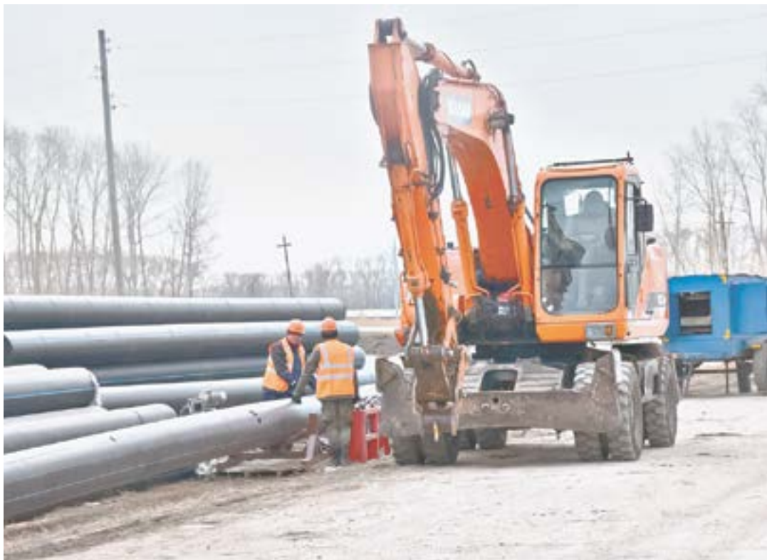
Продолжаются работы по модернизации магистральных водопроводов.
