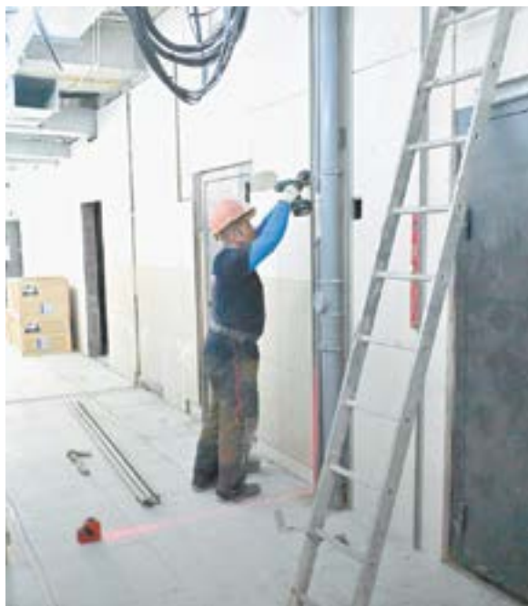
Ремонт идет полным ходом.
