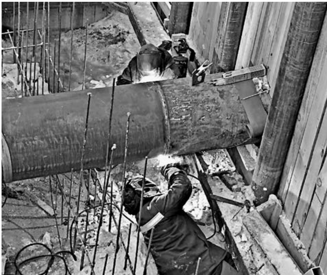
Сварочные работы потребовали почти акробатических навыков.
