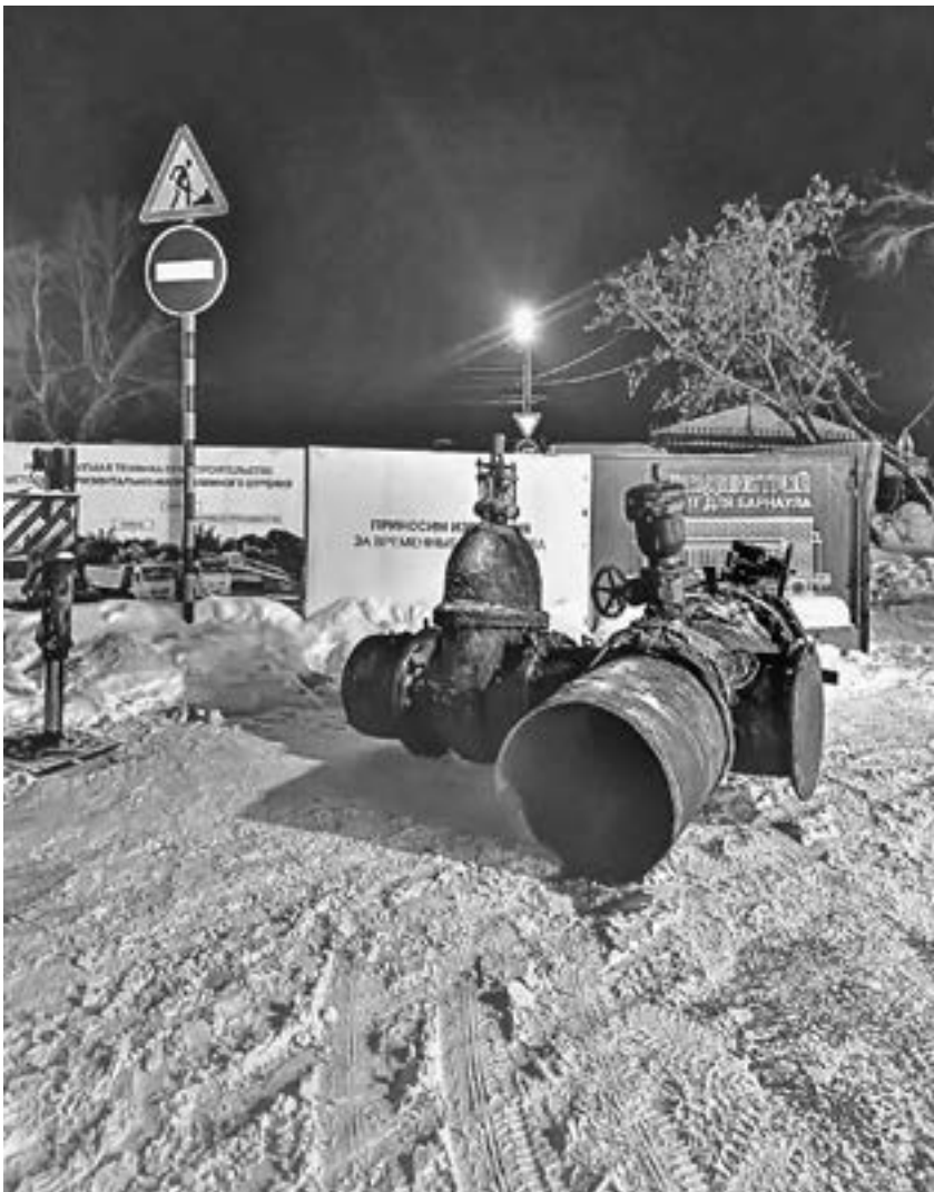
Старые задвижки демонтированы.
