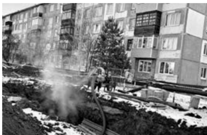
Для откачивания воды установлена помпа.
