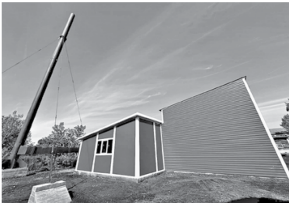
Новостройка в Линёвском.
