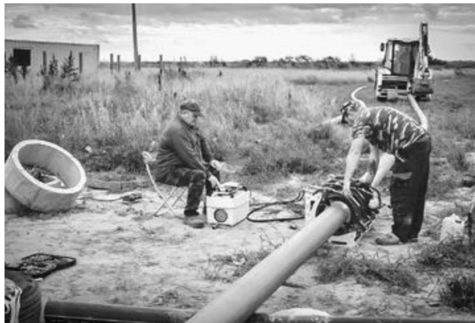
Сварка пластиковых труб.
