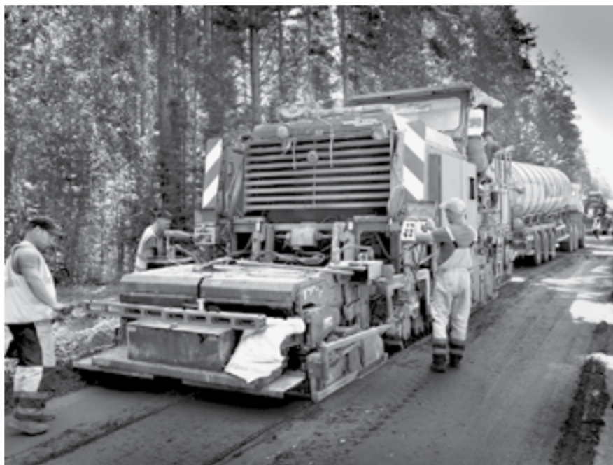
Работы завершены на 40%.
