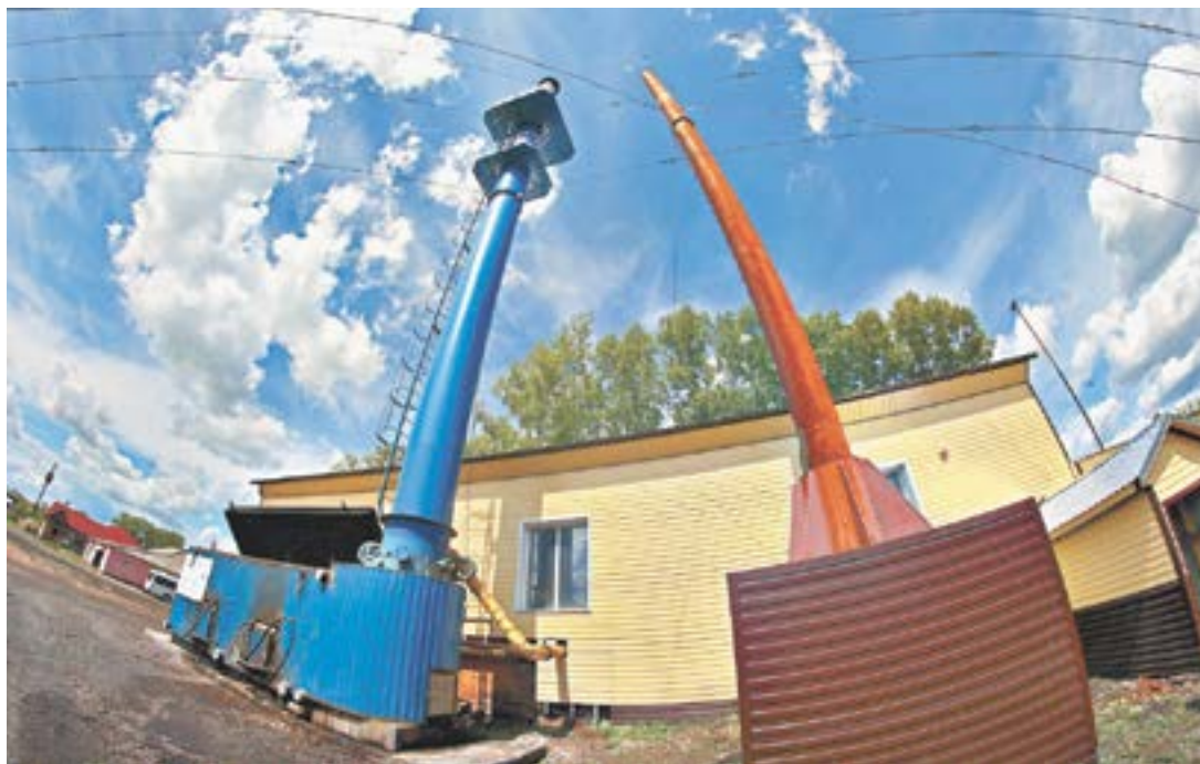
Так выглядят новые котельные (Залесово).
