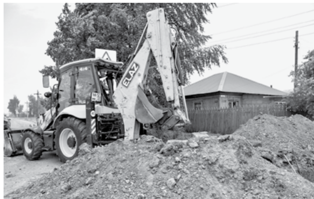
В регионе обновят 113 километров теплосетей.
