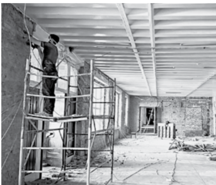
Идет ремонт фойе.
