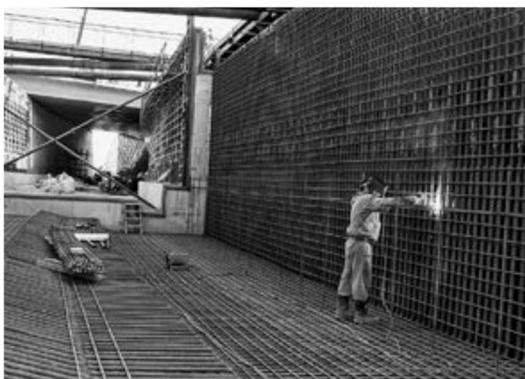
Армирование стен и основания проезжей части.
