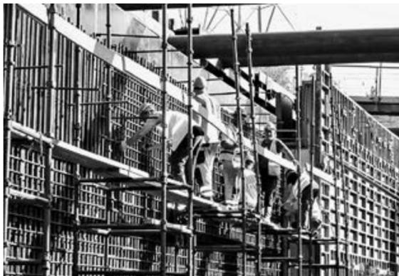
Идет монтаж опалубки в тоннеле.
