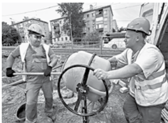
Бетон готовится на месте.
