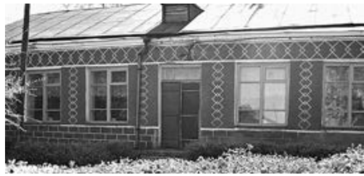
Так школа выглядела до того, как строители начали ремонт.
