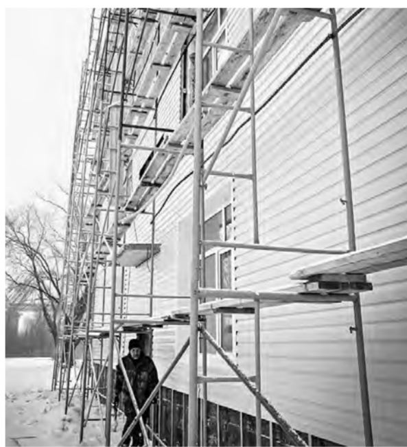
Фасадные работы почти завершены.
