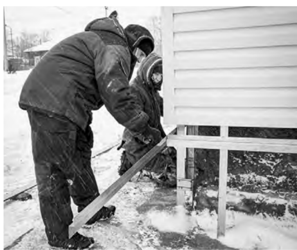
Монтажники работают в любую погоду.
