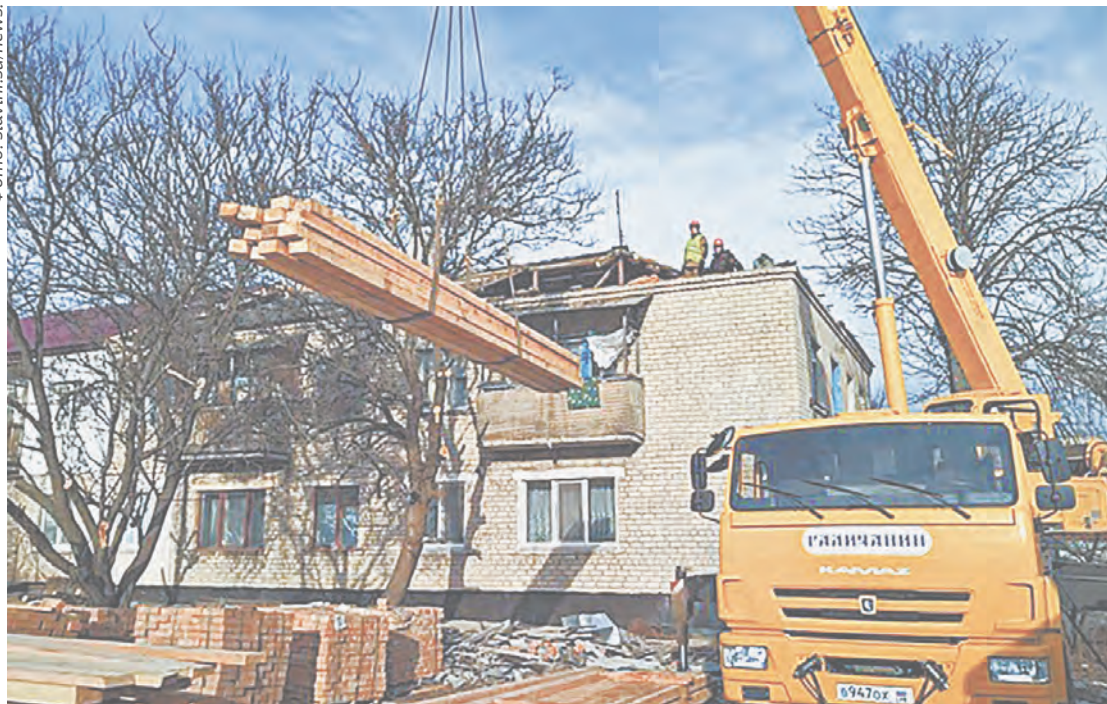
Алтайские строители восстанавливают двухэтажки в Славяносербске, поврежденные в ходе боев.
