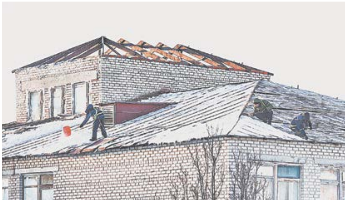
К Новому году основные работы будут завершены.
