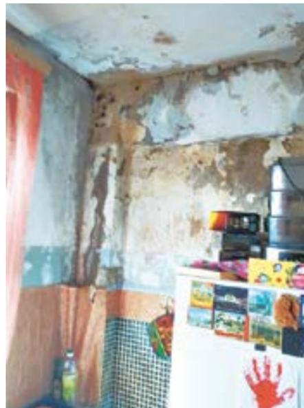
Протечки кровли на верхних этажах.
