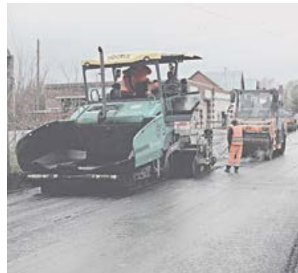
Идет укладка выравнивающего слоя.
