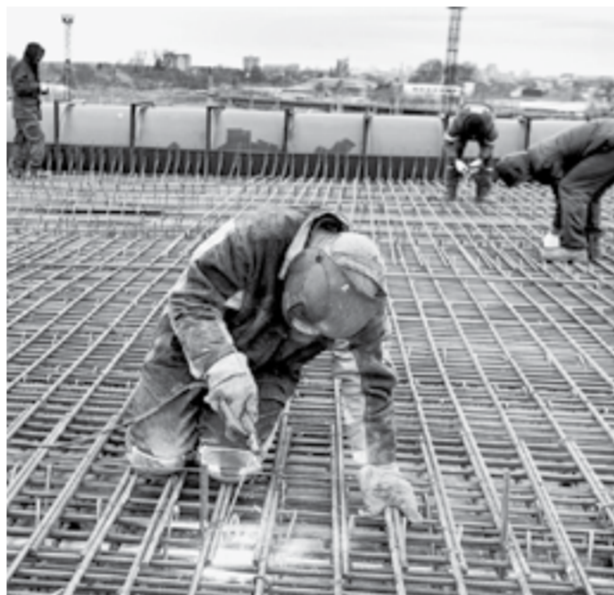
Подготовка к бетонированию.
