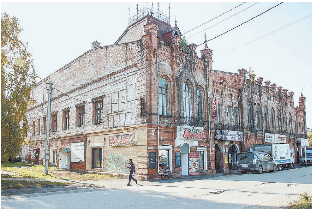
Особняк Винокурова нуждается в срочном ремонте.
