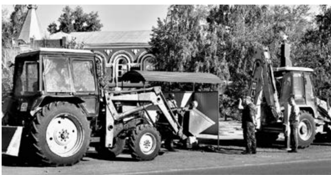
Установка крытых павильонов автобусных остановок в Панкрушихе.
