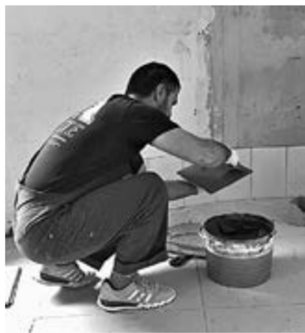
Внутренняя отделка завершается.
