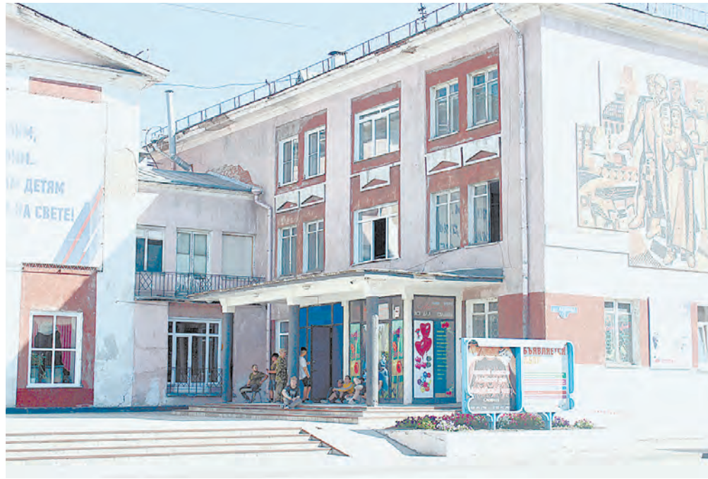
Ремонт проводится в южной части корпуса.
