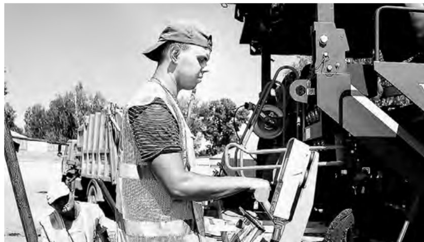
Важно правильно задать параметры на асфальтоукладчике.
