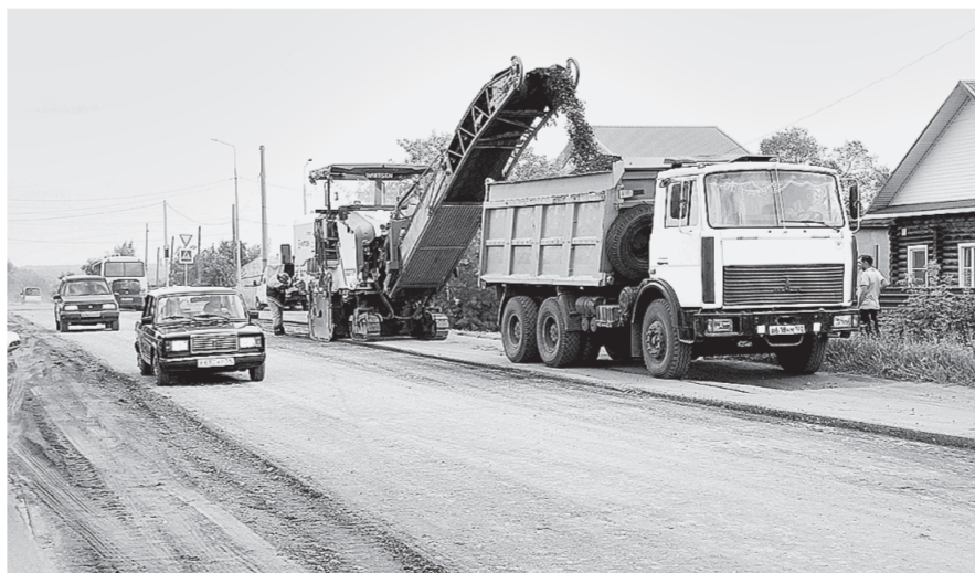
Капитальный ремонт дороги на улице Гагарина.
