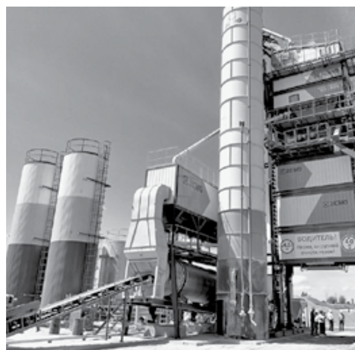
В Рубцовске появился новый асфальтобетонный завод.
