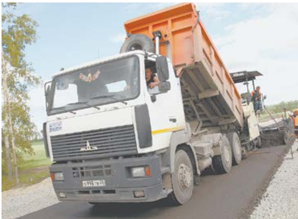
Наш регион получает серьезные деньги на строительство и ремонт дорог.
