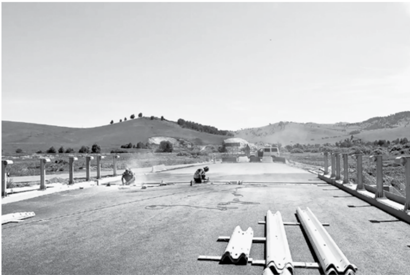
Отремонтируют и мостовые сооружения.
