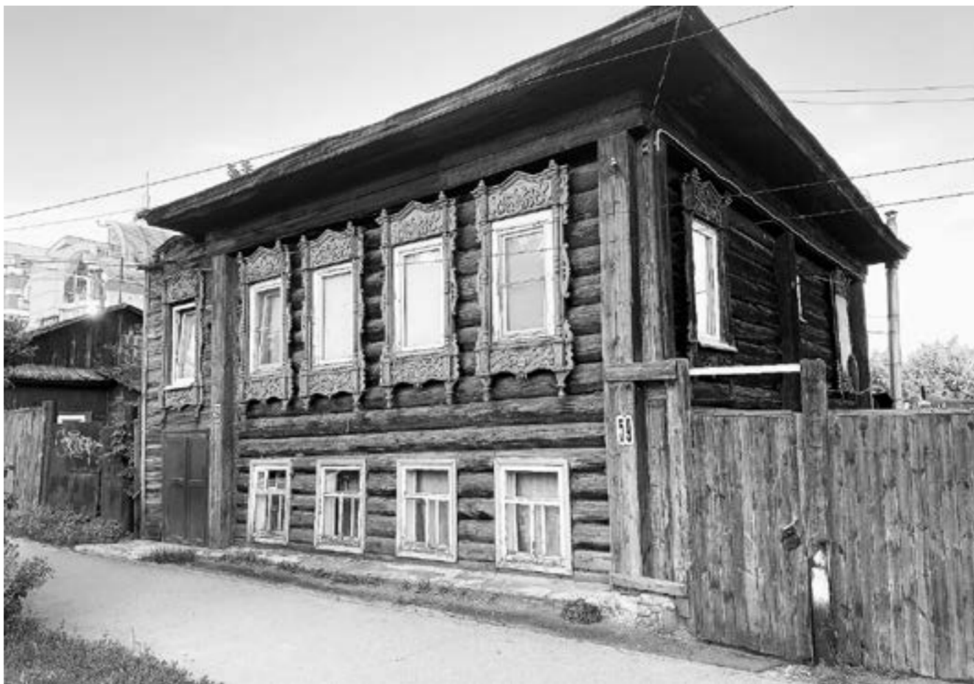
Вид дома до восстановительных работ.
