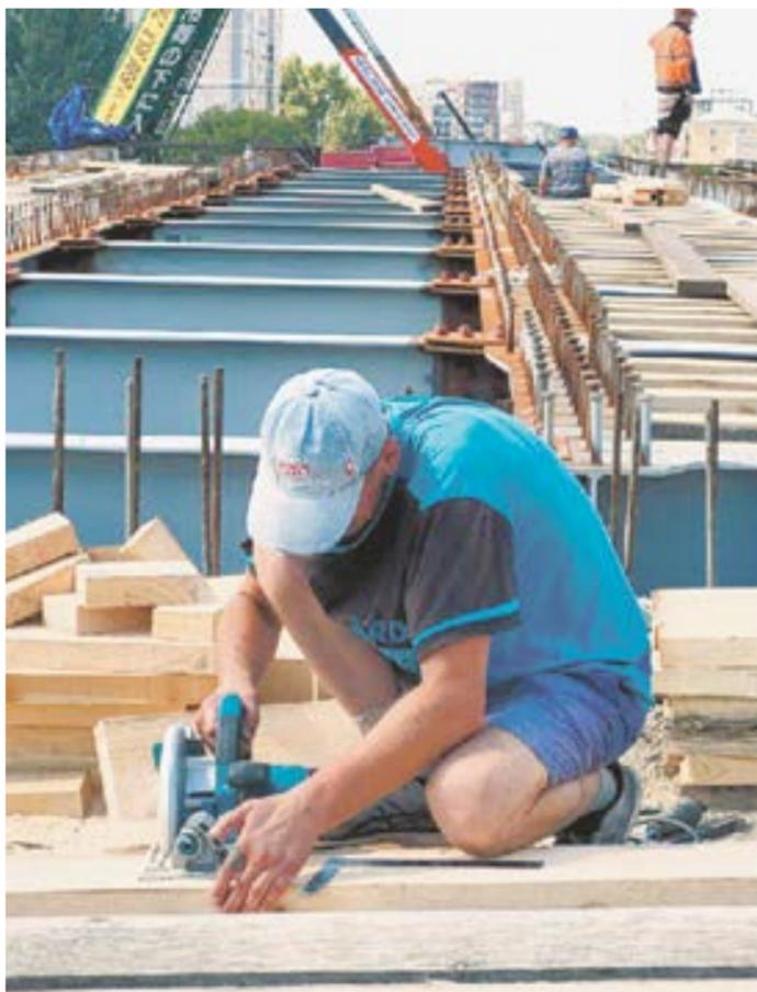
основой для проезжей части самого протяженного пролета. Его длина составит 48,6 метра. Он протянется над железнодорожным полотном. Его строители планируют монтировать путем надвигки.
