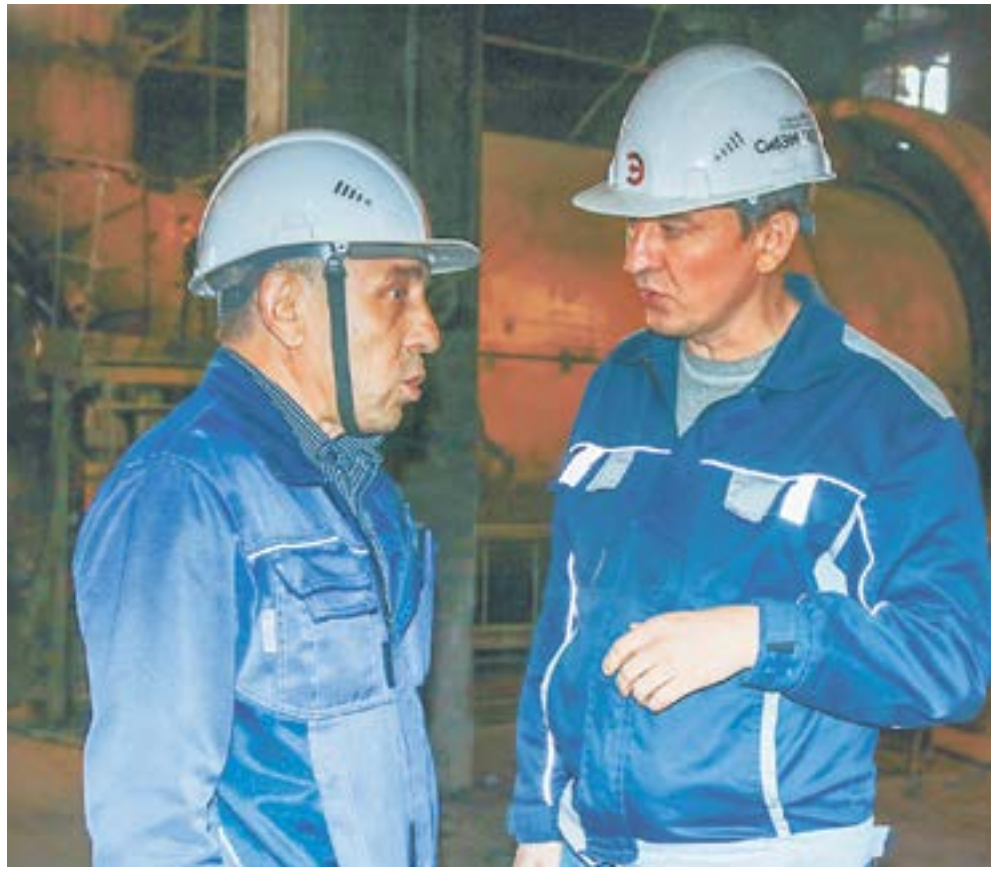
«Сейчас заканчиваем монтаж фундамента», – говорит представитель «Сибэнергомаша» Вадим Улядов Алексею Багринцеву (слева).
