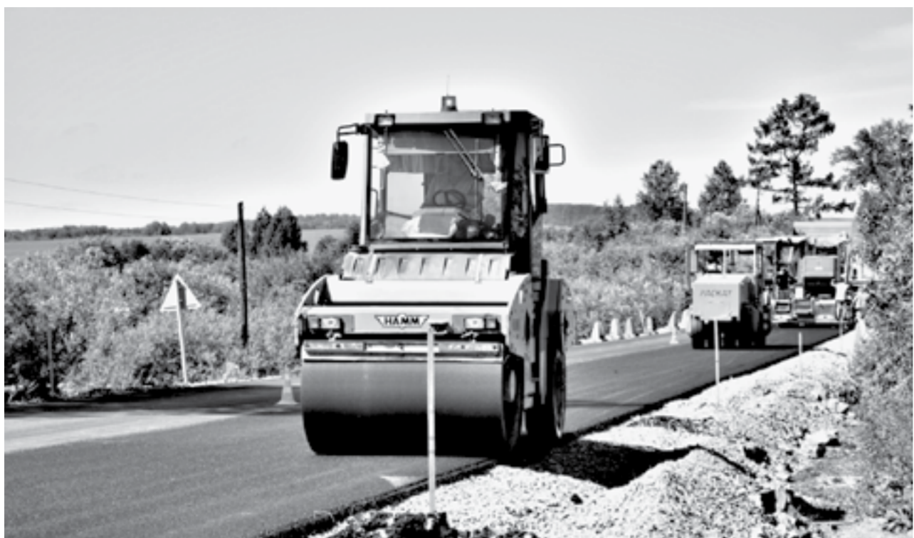
Новый асфальт укладывают взаимно.
