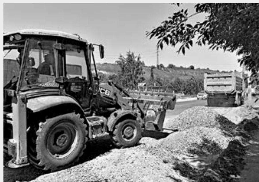
Кипит работа на улице Иртышской.
