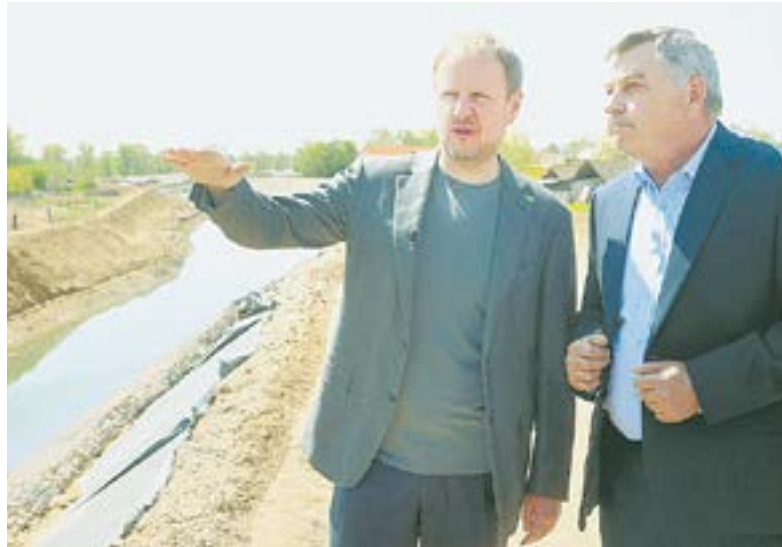
Виктор Томенко проверил, как идет строительство дамбы.
