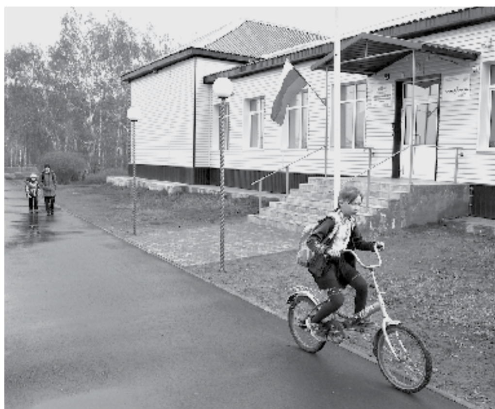
В селе Островном Мамонтовского района отремонтировали школы.
