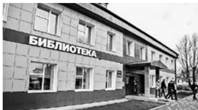
Внешний вид обновленного здания.
