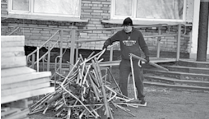
Демонтаж уже завершен.
