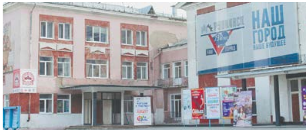
ДК «Тракторостроитель» нуждается в капитальном ремонте.
