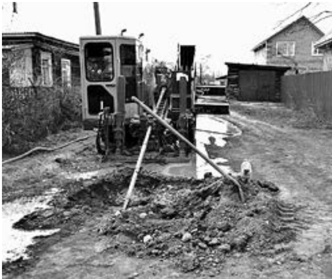
Установка для прокладки газопровода.
