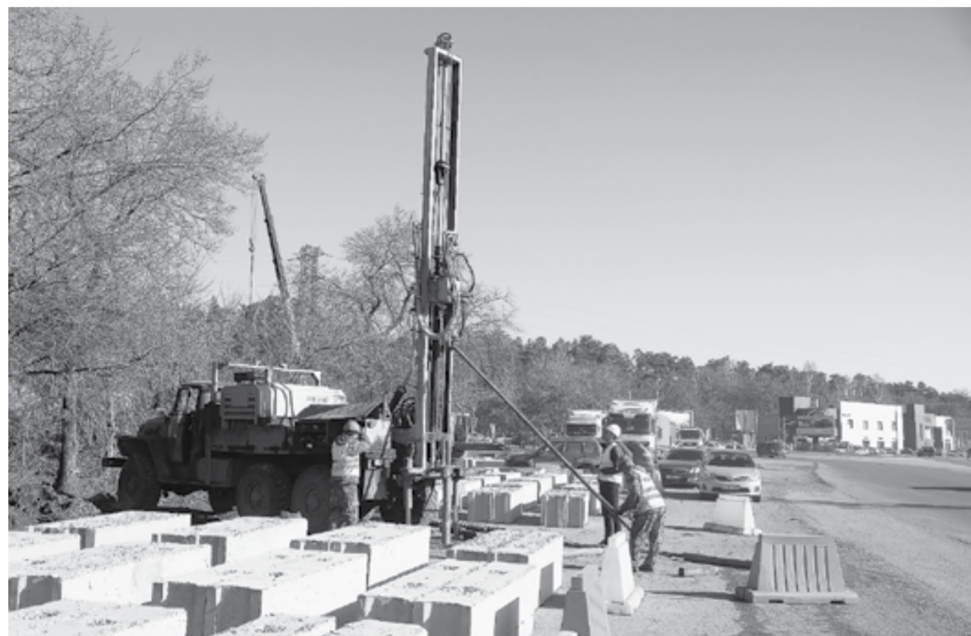
Подрядчик готовится к контрольному бурению грунта.
