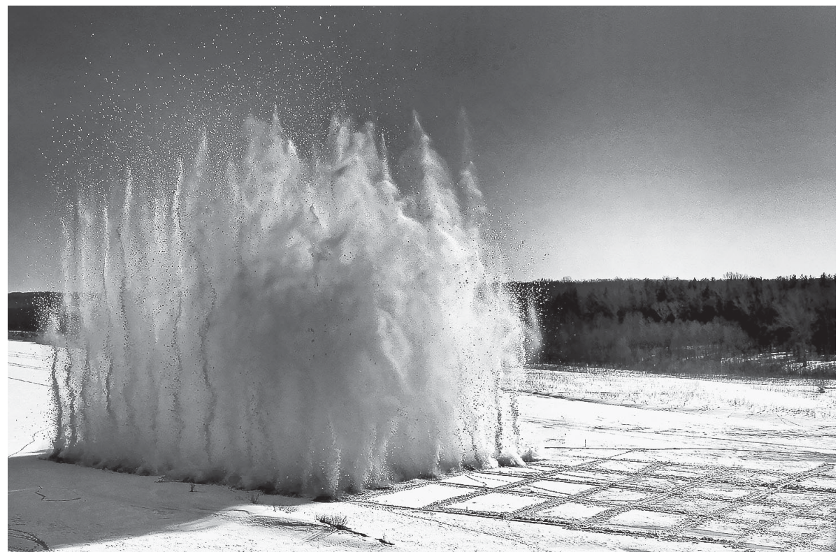
Взрывные работы на реке позволяют избежать ледовых заторов во время половодья.
