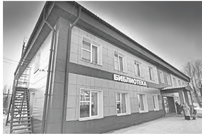
Фасад и кровля тоже новые.
