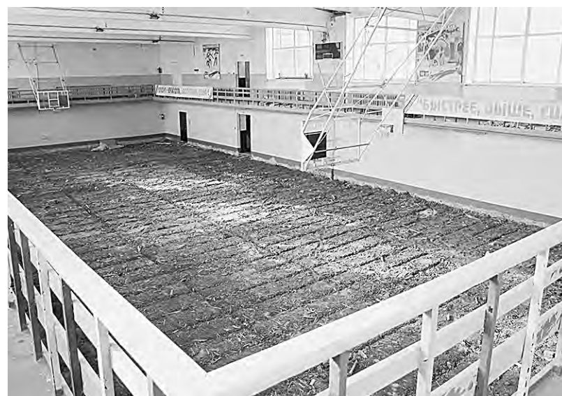
Из всего ремонта — лишь демонтаж пола.
