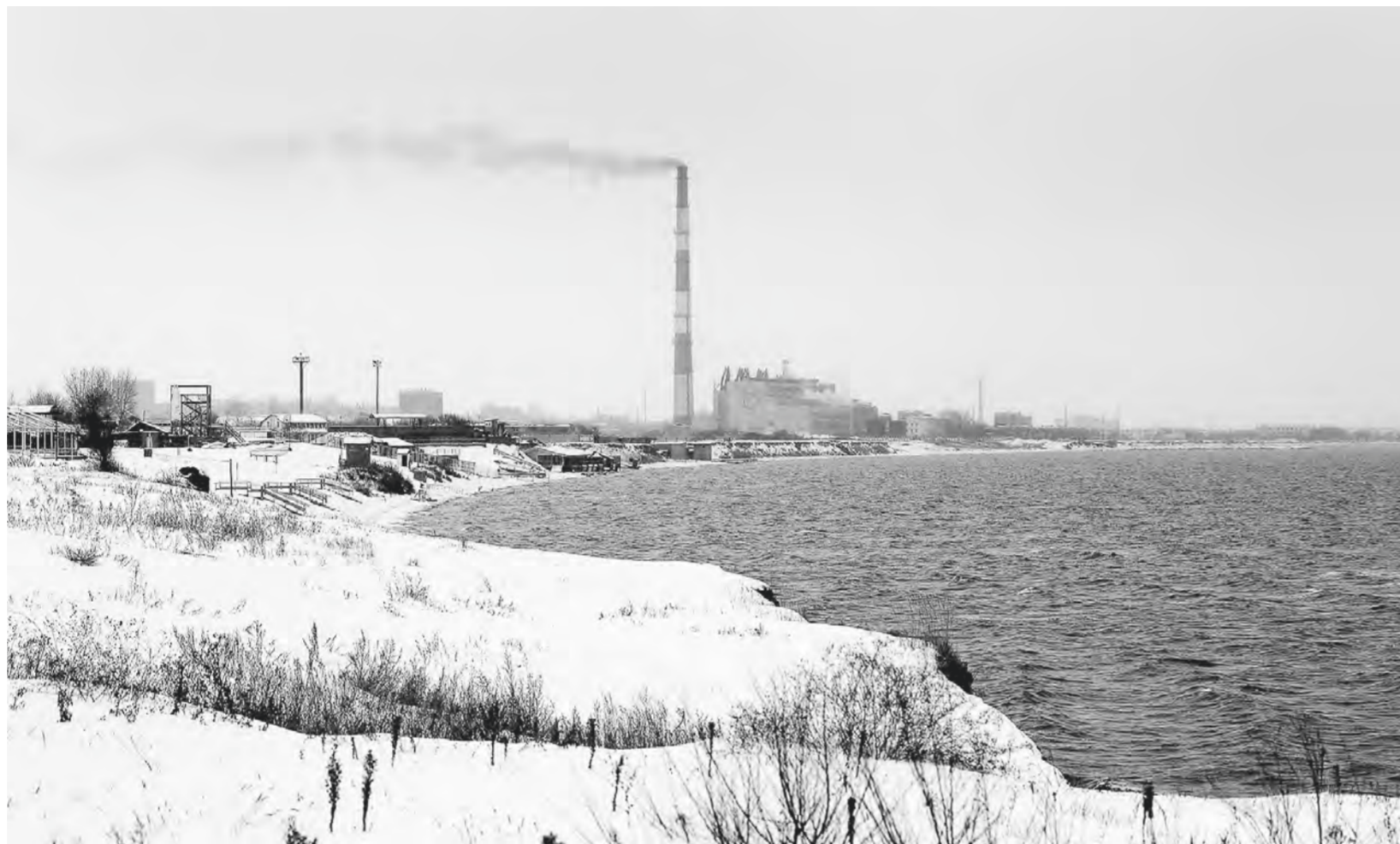
Очистные сооружения у озера Большого Ярового давно ждали реконструкции.
