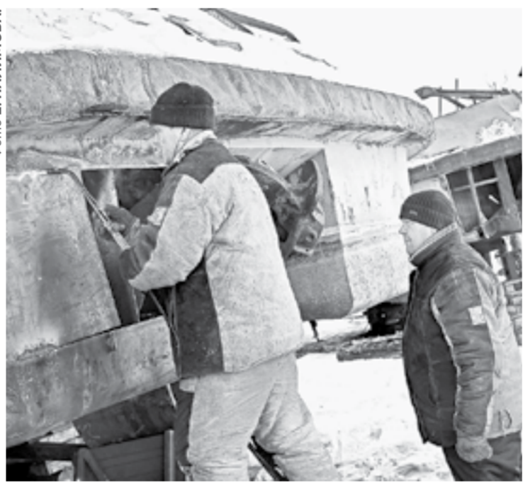
Ремонтируют и большие земснаряды, и малые катера типа «Снегирь» и «Переваль».
