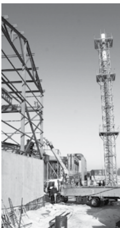
В декабре завершилось строительство угольного склада.
