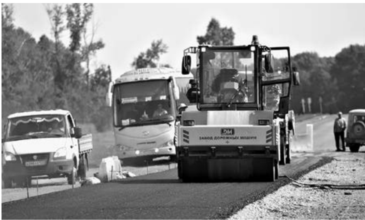
Ремонт популярной в Алтайском крае трассы на Кулунду продолжится и в следующем году.
